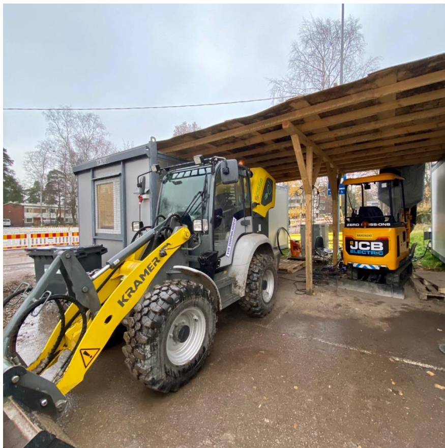
Kulosaaren urakan täyssähköiset pyöräkuormaaja ja minikaivuri latauksessa. Kuva: Tim Karike.
