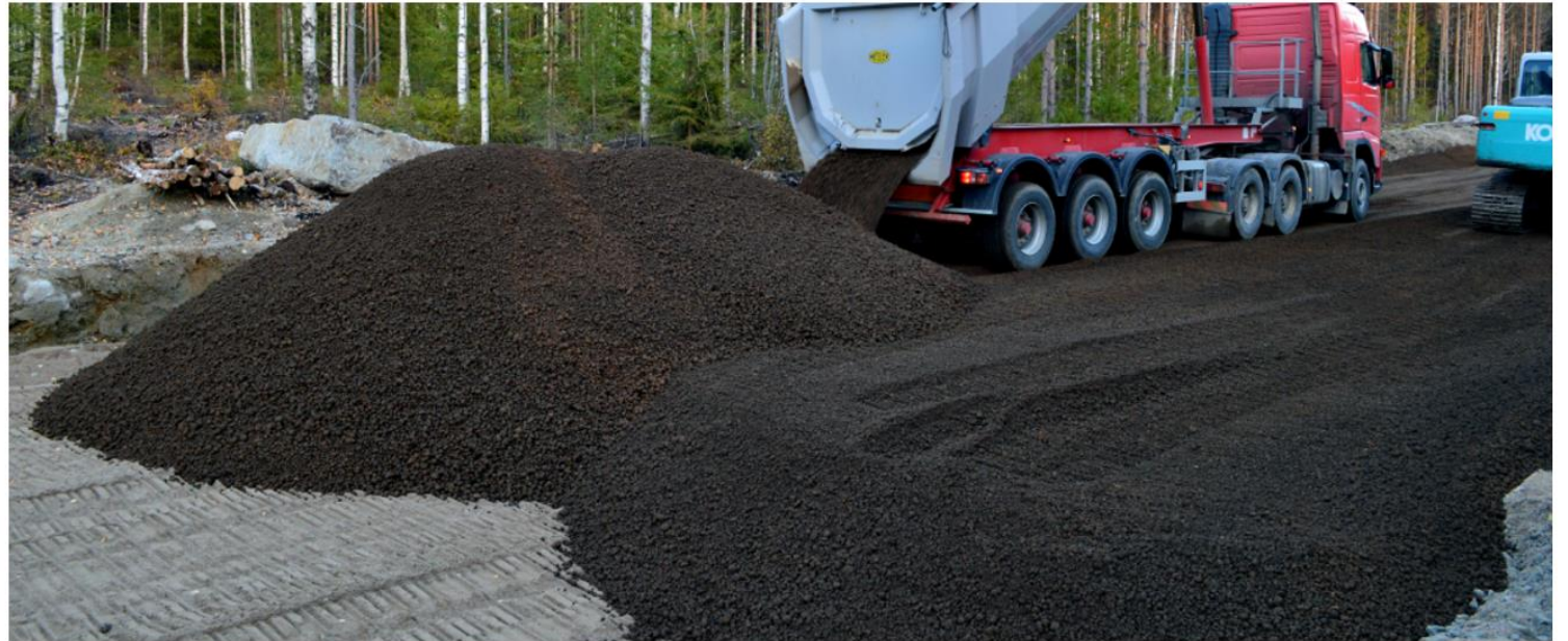
Kuva L3.5. Tien rakentamista rakeistetulla tuhalla ( https://www.ecolan.fi/fi/uutiset/tuhkara-keesta-uusi-apu-routimiseen/ )
