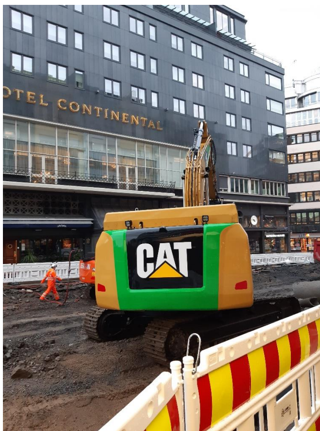
Oslon kaupungin työmaalla toimiva sähkökäyttöinen kaivinkone. Kuva: Niina Ruuska.
